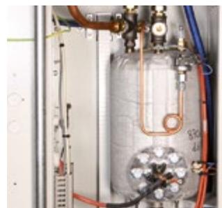
**DER EINGEBAUTE DAMPFERZEUGER**
